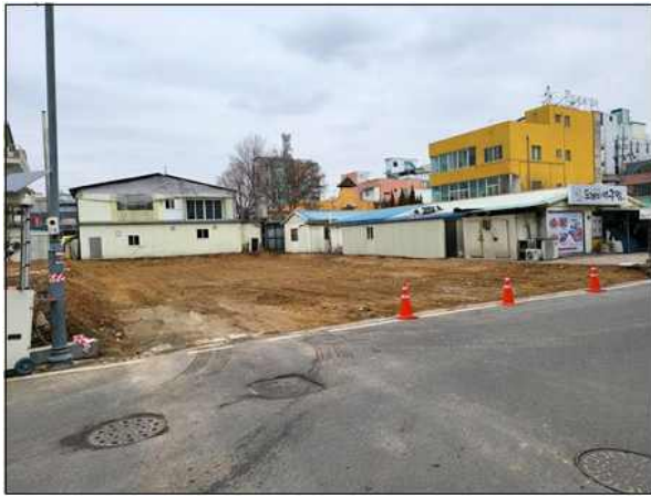
기 건물 철거 후 현황
